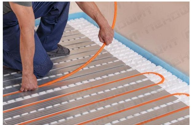
После размещения труб, подключения их к коллектору и после испытания давлением, можем приступить к укладке листов ГВЛВ толщиной 10 мм в два слоя, это выравнивающий, несущий и термораспределительный слой, являющийся основой для финишной отделки пола.
