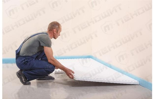
**Шаг 3:** В разложенные маты теплого пола укладываются термораспределительные пластины.
